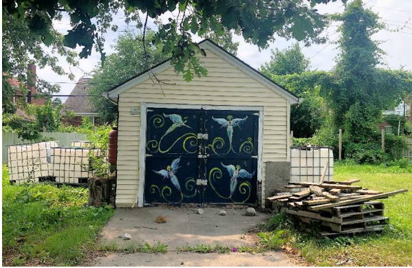
Garage Door at 4 Angels Garden Katie Carlisle
