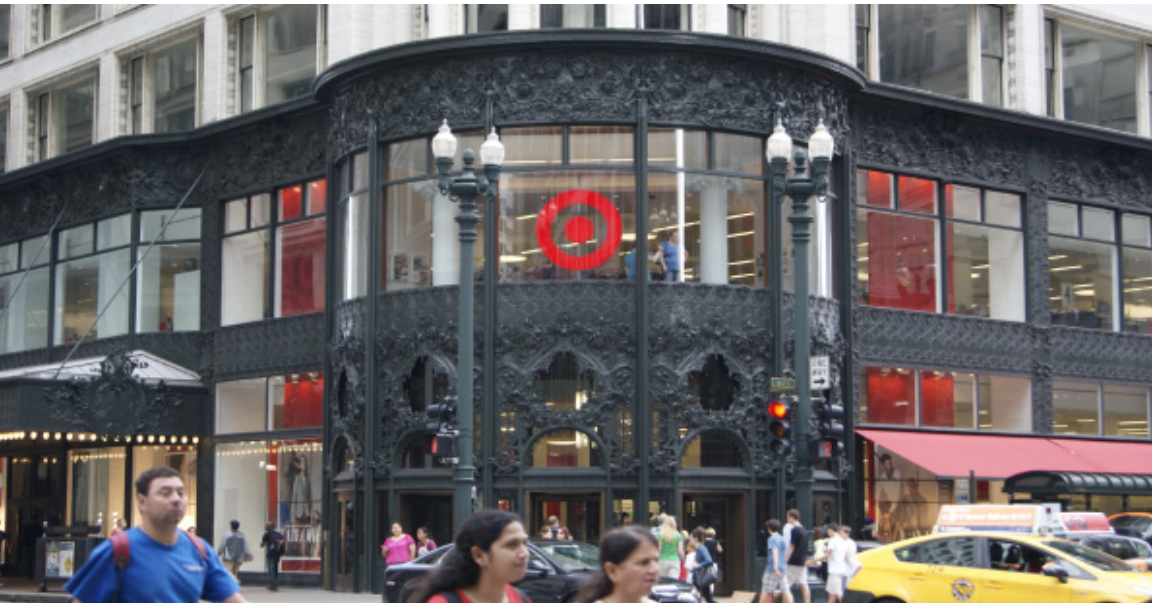
Exterior Facade- Chicago, IL
