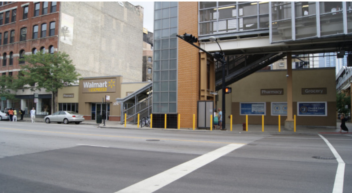
Exterior Facade - Chicago, IL
